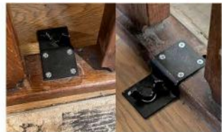
Banken & kopschotten vastzetten met vleugelmoeren
